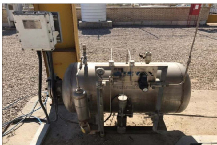
شکل ۱ سیستم بودار کننده تزریقی موجود در CGS امام حسین بندرعباس
