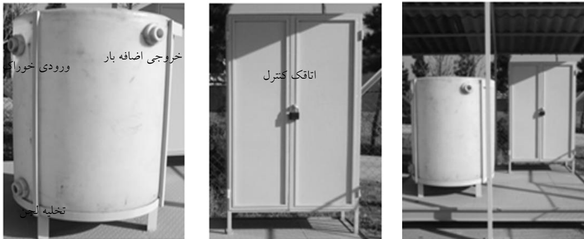
شکل ۳- تصویر مخزن هوادهی و اتاقک کنترل
